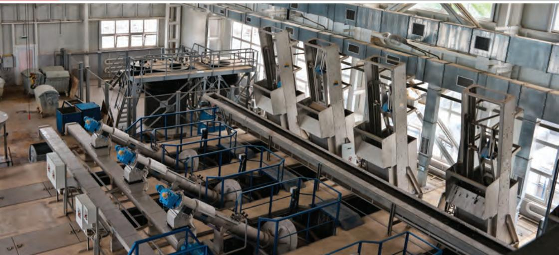
**Технология «MY MET»** – это ряд готовых технологических решений, объединяющих очистку от механического мусора на решетках, удаление минеральных веществ (песка) и первичное осветление сточных вод. В зависимости от исходного состава сточных вод и технологического процесса предусматриваются различные вариации оборудования для механической очистки сточных вод.
