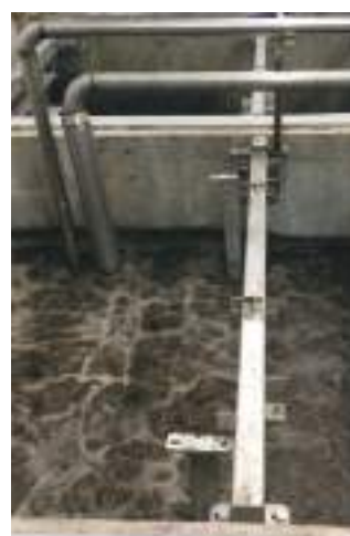
Мембранные кассеты и биореакторы
