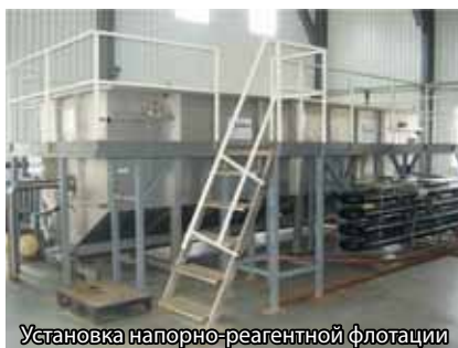
Установка напорно-реагентной флотации
