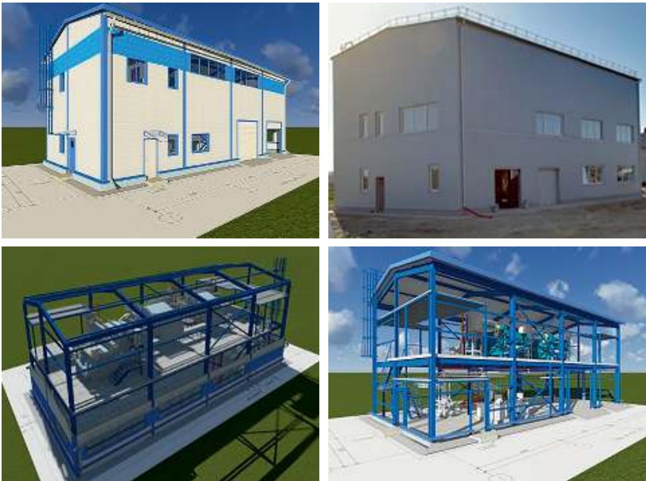
**Рисунок 1. Цех механического обезвоживания: 3D визуализация и построенный цех**
