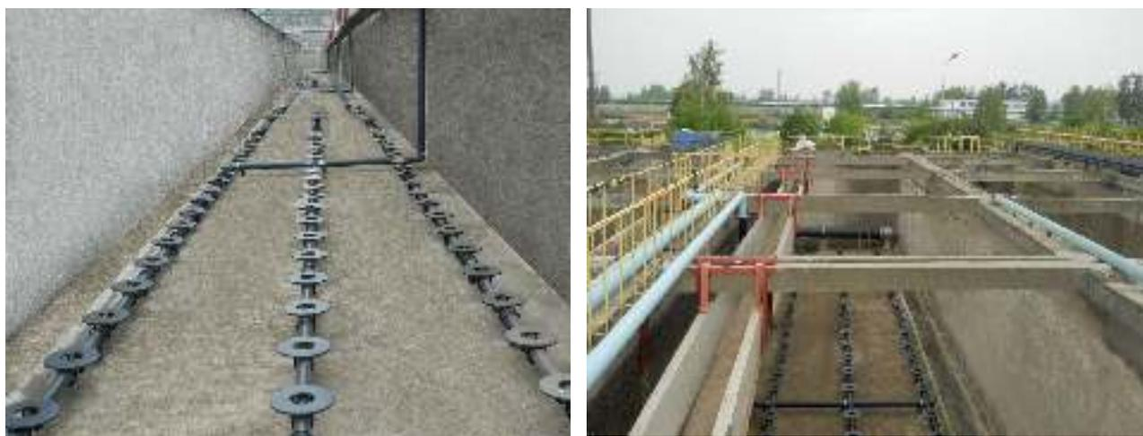
**Рис. 6. Аэротенки после реконструкции перед заполнением**
