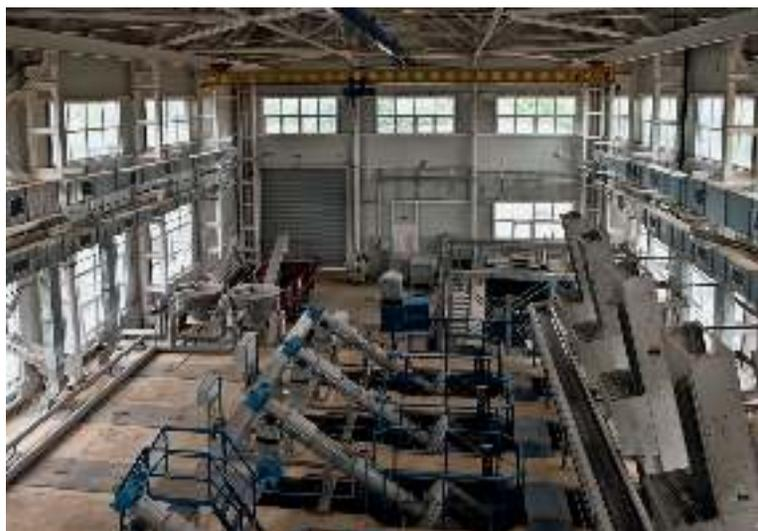
**Рис. 5. Цех механической очистки с решетками грубой (на заднем плане) и тонкой очистки (на переднем плане)**
