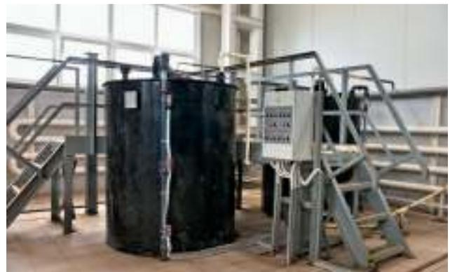
**Рис. 4 – РЕШЕТКИ ТОНКОЙ ОЧИСТКИ И УЗЕЛ ХИМ. УДАЛЕНИЯ ФОСФАТОВ**
