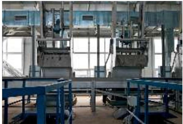
**Рис. 3 – ПРИЕМНАЯ КАМЕРА И РЕШЕТКИ ГРУБОЙ ОЧИСТКИ**
