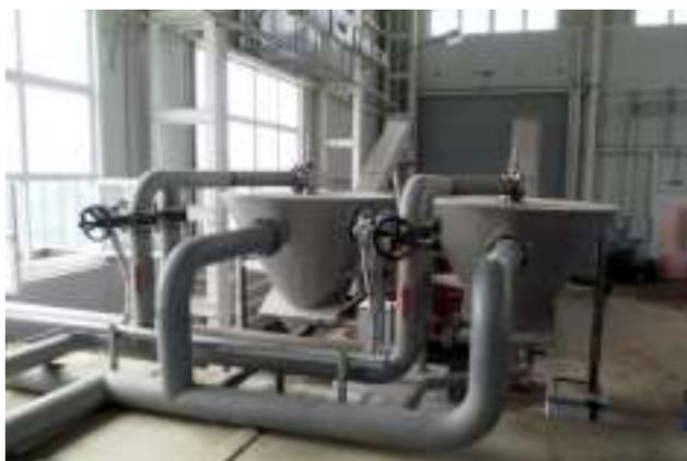
**Рис. 7 – Первичные отстойники (вид снаружи и внутри)**
