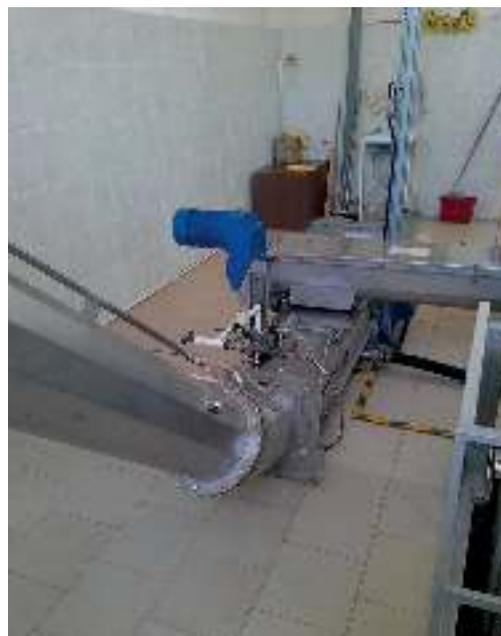
Особенностью данного инженерного решения является специальное устройство транспортера выгрузки с пресса-уплотнителя (рис. 3) – так как КНС находится ниже отметки уровня земли была применена увеличенная длина шнека транспортера и дополнительное устройство промывки отбросов для перекачки отбросов в контейнер, который находится на поверхности.
