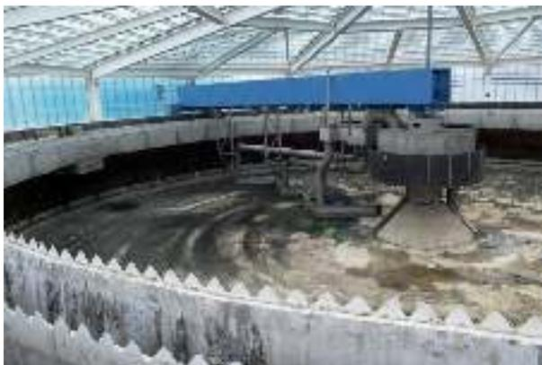
**Рис. 9 – Вторичные отстойники (в работе и опорожненные)**
