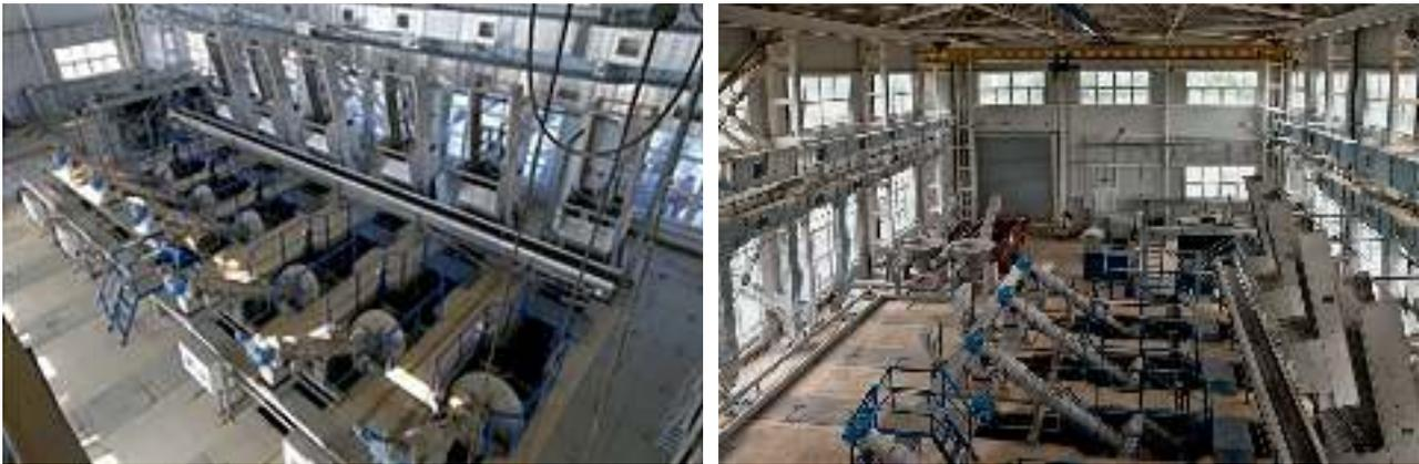
**Рисунок 1. Цех механической очистки с решетками грубой и тонкой очистки г. Сочи**
