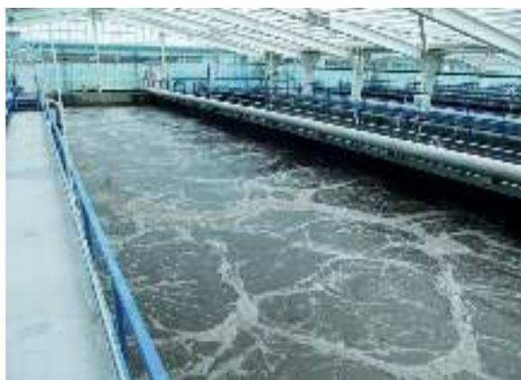
**Рис. 8 – Аэротенки нитри-денитрификации и их технологическая схема работы**
