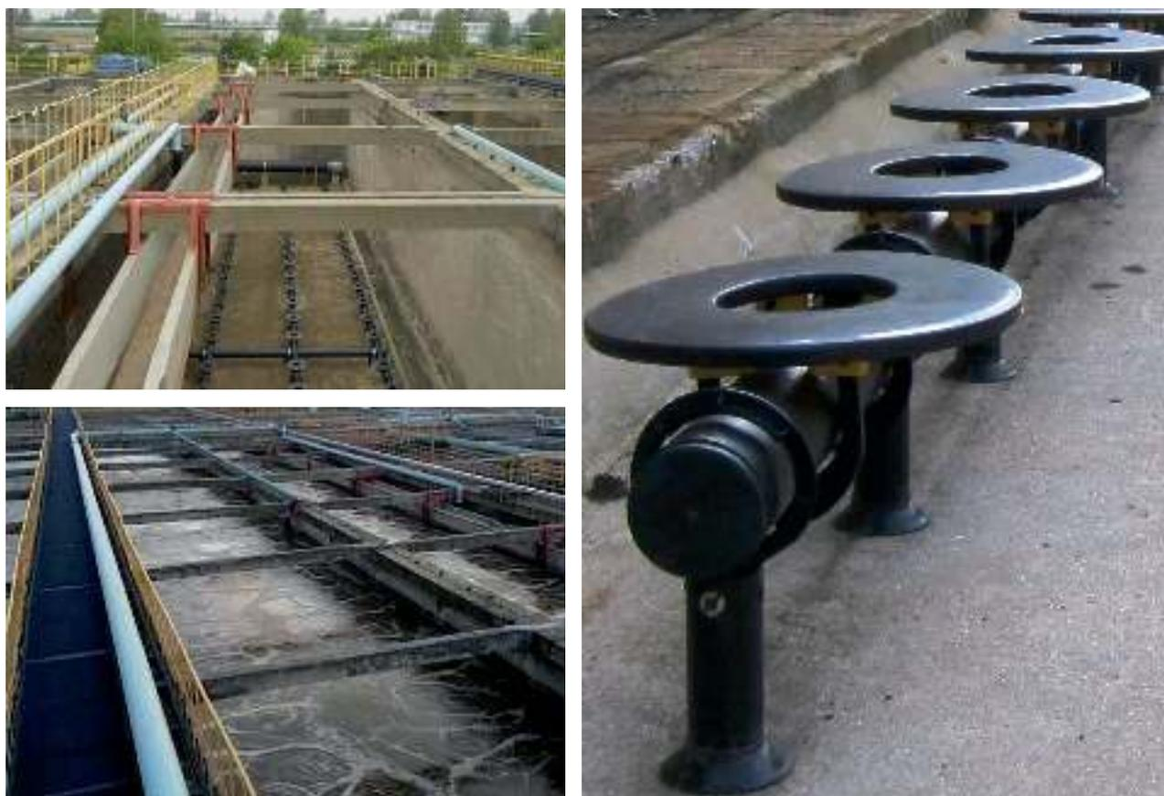
Рисунок 4 – Система аэрации, уложенная на дне аэротенка и в работе
