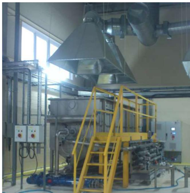
В процессе выполнения пуско-наладочных работ была достигнута высокая эффективность очистки по жирам – 96-99% при низких эксплуатационных затратах. Обслуживание локальных очистных сооружений не требует постоянного присутствия эксплуатационного персонала благодаря высокому уровню автоматизации технологических процессов.
