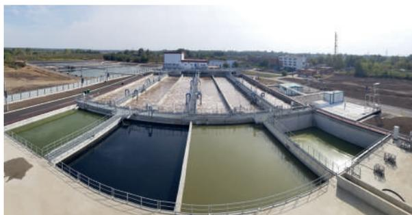
Разработанная технология обеспечивает очистку воды до требований к качеству оборотной воды и норм на сброс в водоем рыбо-хозяйственного использования 2-й категории. Схемой также предусмотрено обезвоживание образующихся в процессе очистки воды осадков и избыточного ила.
